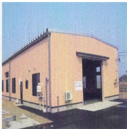
生ごみ堆肥化施設
